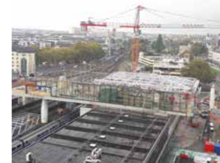
Les travaux du clos I couvert à l'automne 2018.
