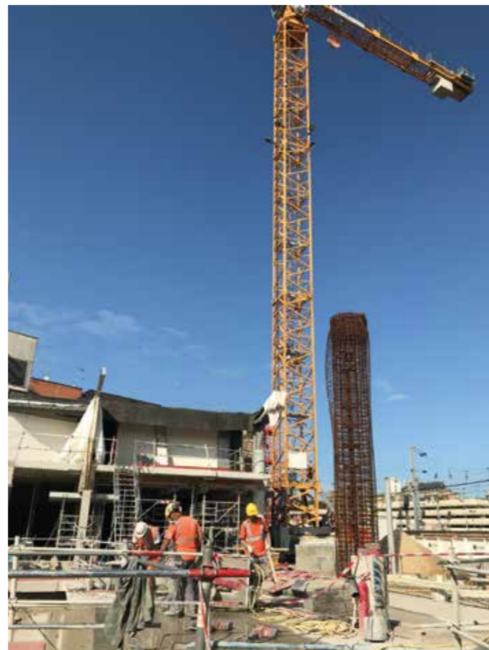
Le coffrage des piles, conçu pour supporter 25 tonnes de béton.
