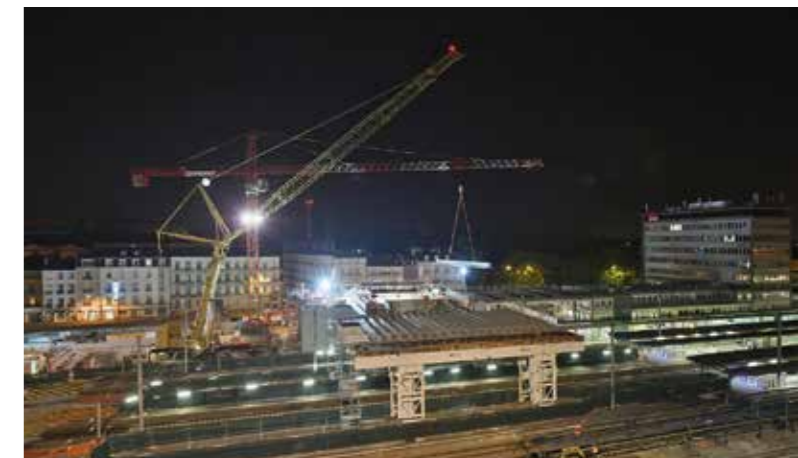
La grue Demathieu Bard de 700 tonnes.
