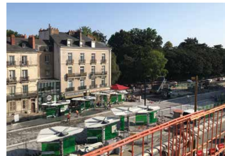
Le nouvel arrêt de tram Gare Nord - Jardin des Plantes vu de la future mezzanine
