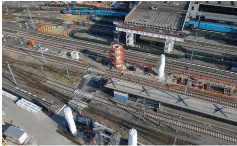
Les piles se dressent et la mezzanine prend forme au nord de la gare.
